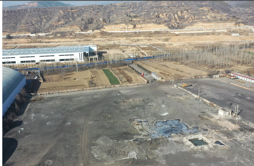
厂区西侧鸿金煤业工业场地
