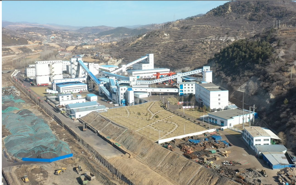
厂区东北侧金谷煤业
