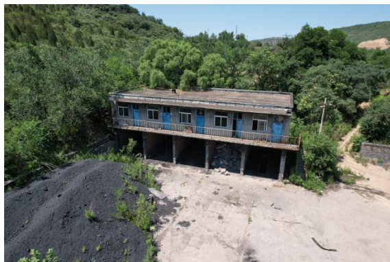
项目原有建筑物 1
