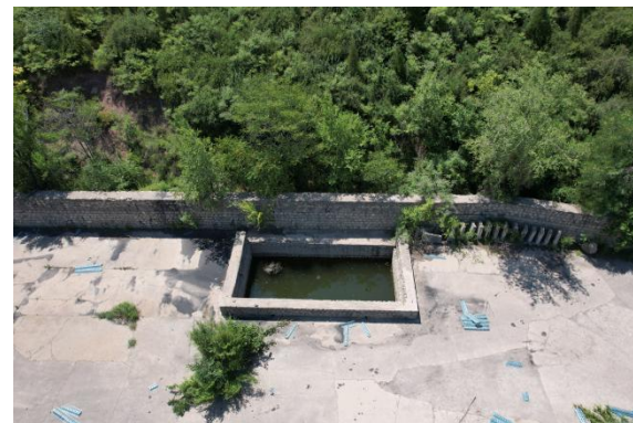
项目原有建筑物 2
