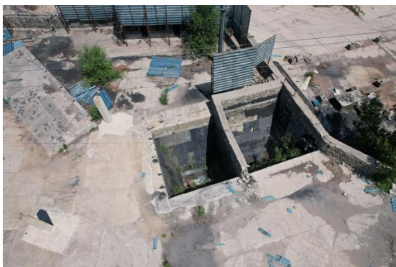
项目原有建筑物 3
