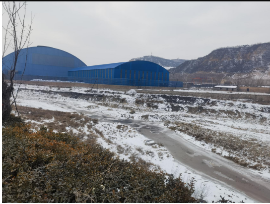
镁合金跨河连接桥现状
