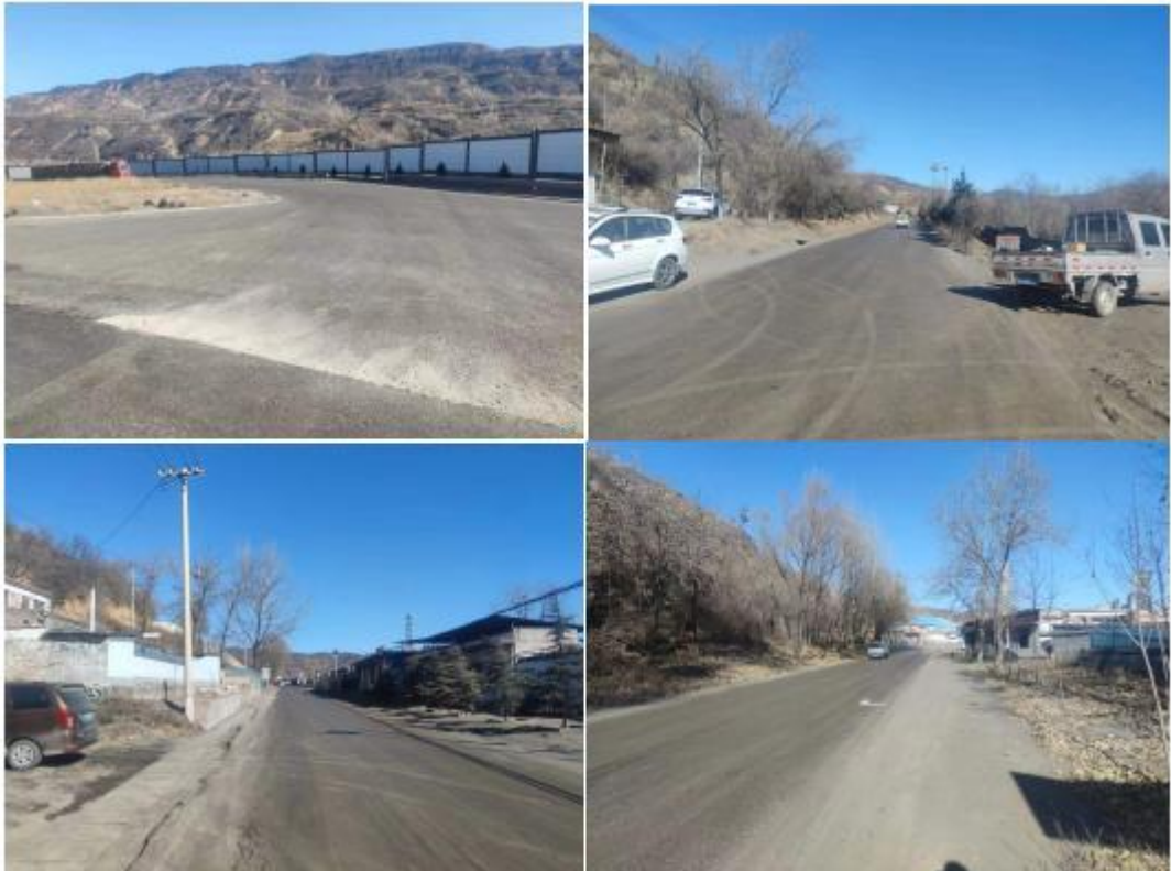
国道旧线现状
