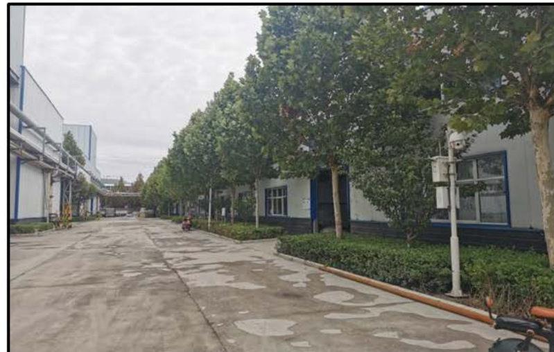
租赁车间西侧及南侧
